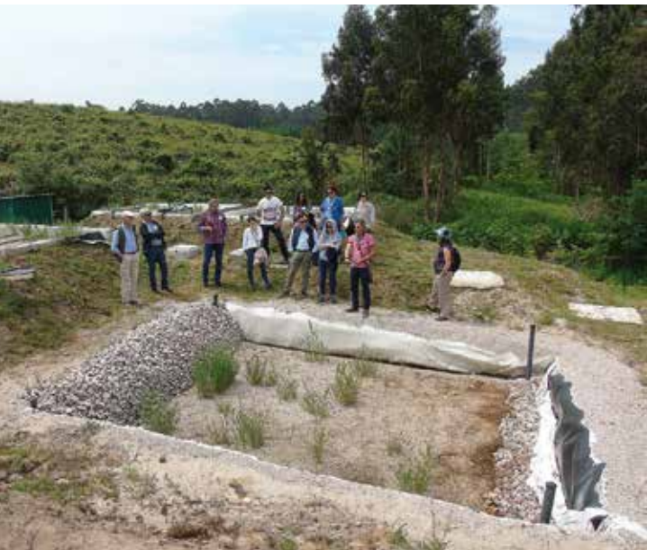
Sistema Wetwine: humedales implementados en la bodega Santiago Ruiz (Galicia).
