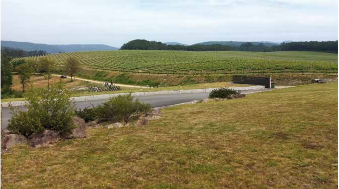
Figura 5. Viñedo de la bodega Santiago Ruiz donde se puede observar la planta de tratamiento.
