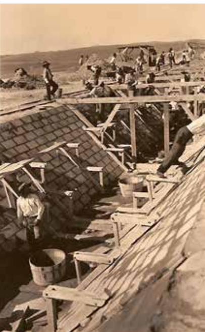
Campina da Idanha (Obra nº. 8)
