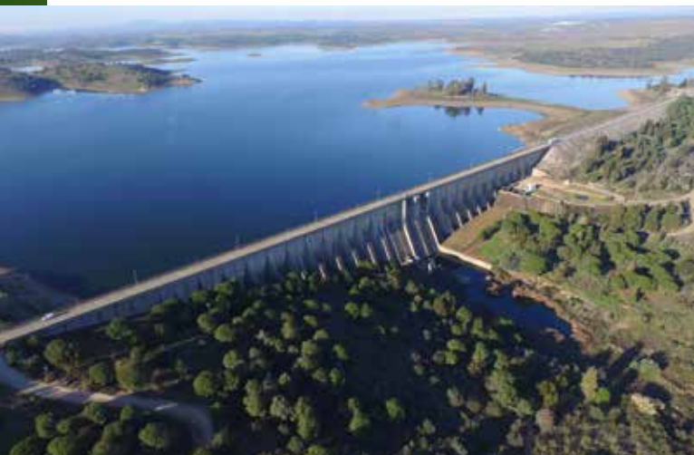
Barragem do AH do Caia - 1.º Aproveitamento do Plano a ser concluído [1967]
