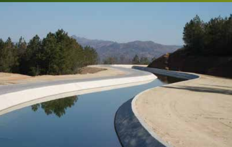
Canal condutor geral da Cova da Beira
